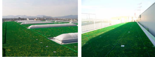
佐賀鉄工所 1,539㎡ 「折板屋根」
