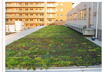
石川倉庫 200㎡「折板屋根」
