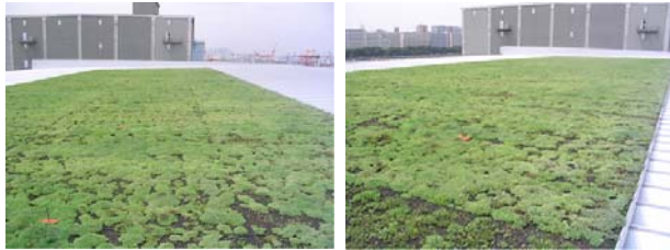
JR貨物ターミナル 1,557㎡ 「折板屋根」
